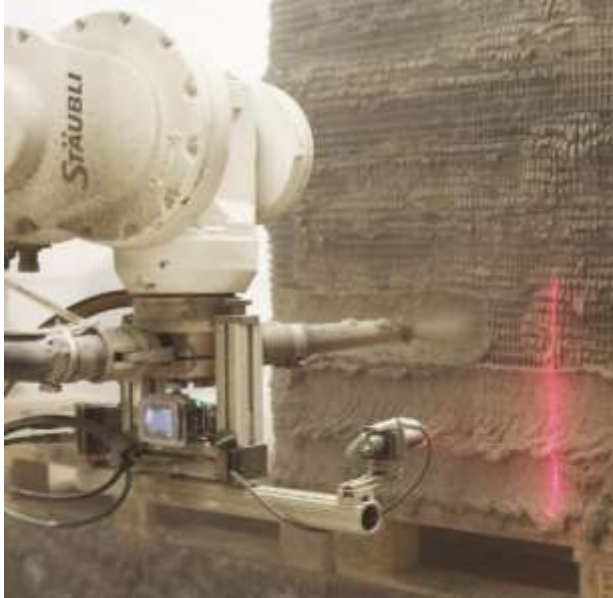
3D-Druck mit Zement-Compound [TU Braunschweig]
